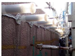
ジオポリマー 注入状況
