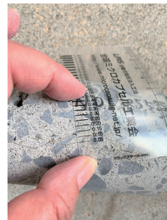
注入後のコア
